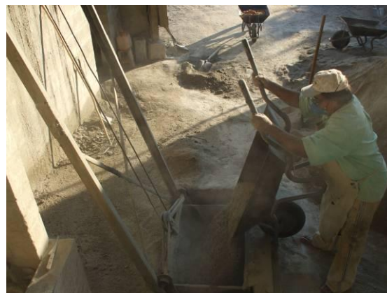
(b) Colocação de material no skip 13 *
