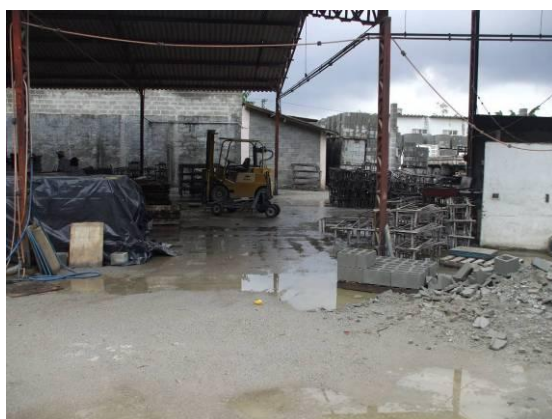
(e) Galpão, empilhadeira e blocos a moer 14 *
